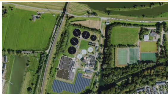
Rioolwaterzuiveringsinstallatie (naast de dijk)
